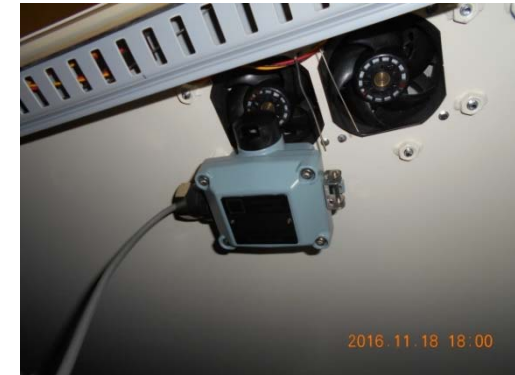
吸引式ガス検知器(左)と 拡散式ガス検知器(右)
