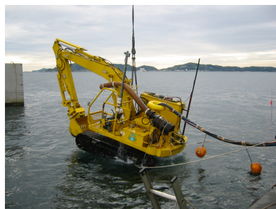
図4 水中バックホウ投入状況（実海域試験時）
