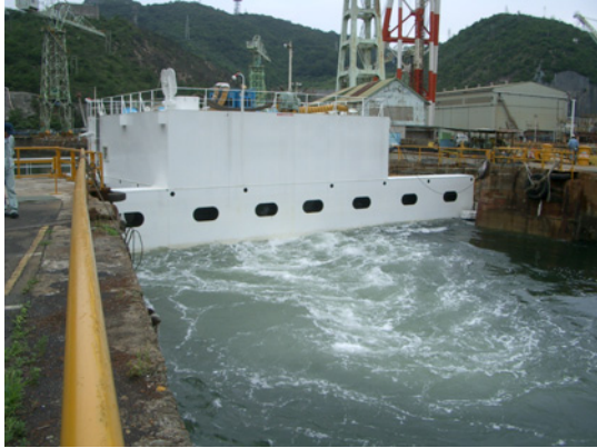
図7 電動機最大出力時のドック水面
