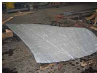
図2: 曲率線展開によるS字のねじれ外板施工
