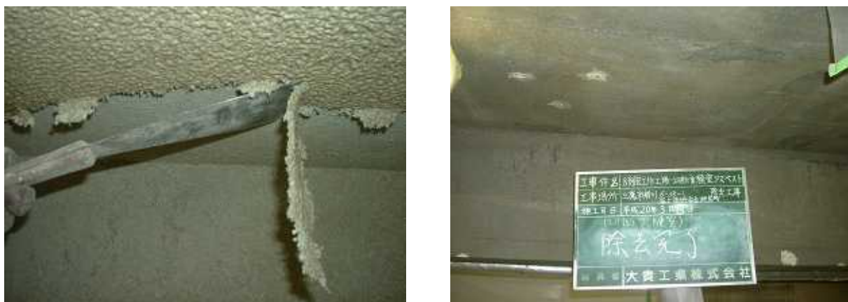
図3. 5 アスベスト除去工事 (左側：作業状況、右側：完了状態)
