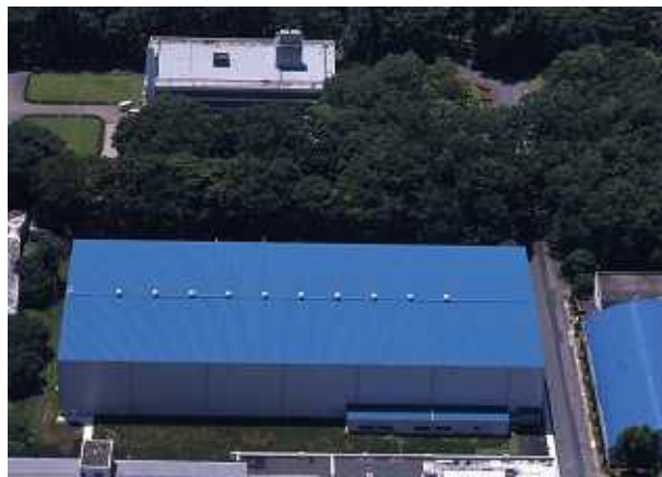
水槽建屋（現状）
