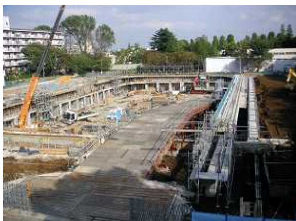
水槽建屋下部工事（19年10月）
