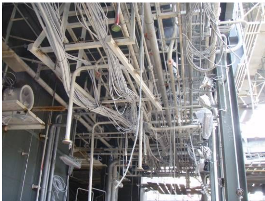
ブロックを跨ぐ配線の場合、片方はバンド留めまでし、逆側や上下に行く線は束ねておく。
