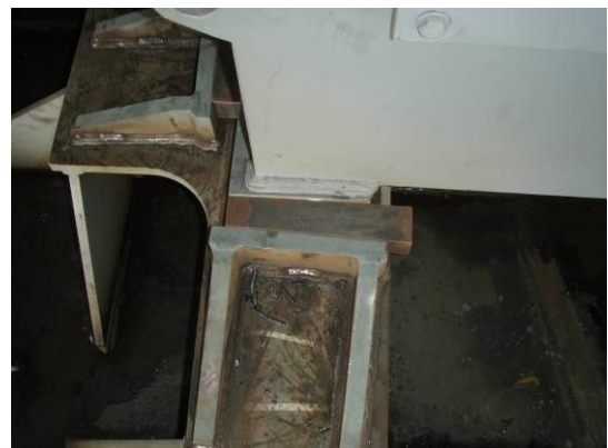
甲板機器の鋼製ライナによる固定
