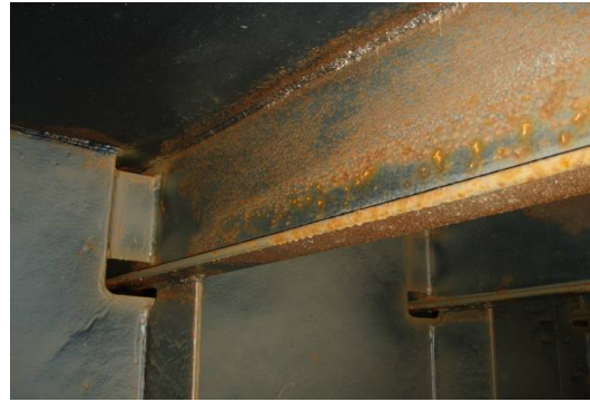
ロンジだけに錆が集中している様子
