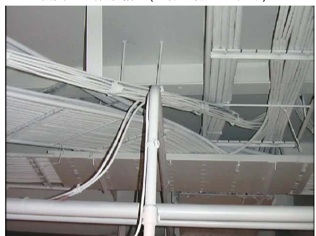
配管の障害物(電路)
