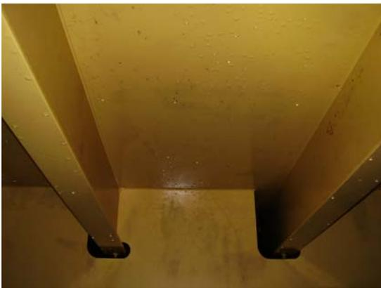
バラストタンクに塗布した VOC 量 50g/L の防食塗料の 2 年後の状況
