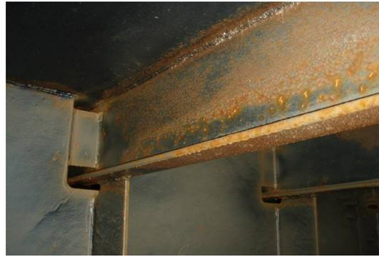
写真 ロンジだけに錆が集中している様子
