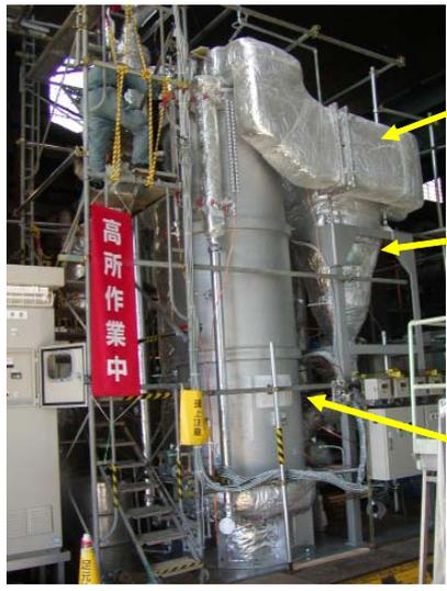
図2 実証試験用流動層ボイラー
