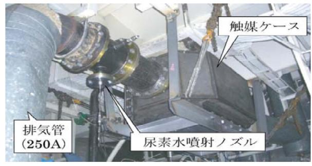
図3 セメント運搬船に搭載したSCR脱硝システム
