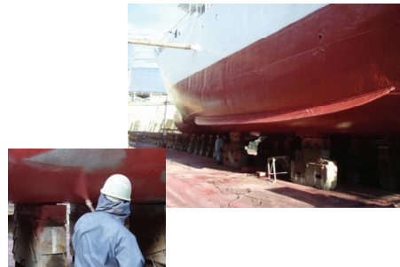
開発した低VOC防汚塗料を塗装した練習船「弓削丸」
