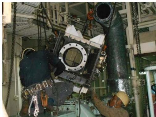
図3 SCR脱硝システムの撤去工事の様子
