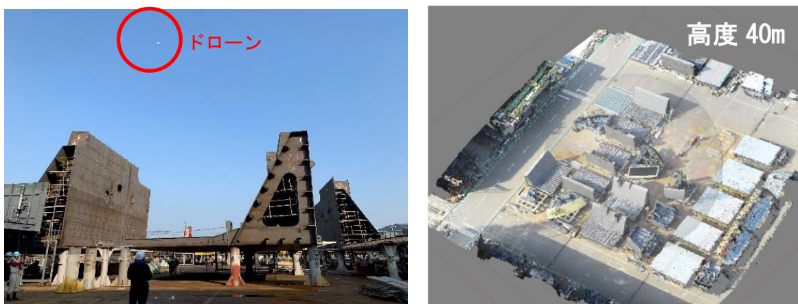
図3 造船所でのドローンによる定盤管理
