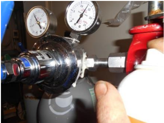
図3 水素用圧力調節器の漏洩試験
