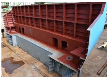
図 1-2 実船総組ブロック(写真)
