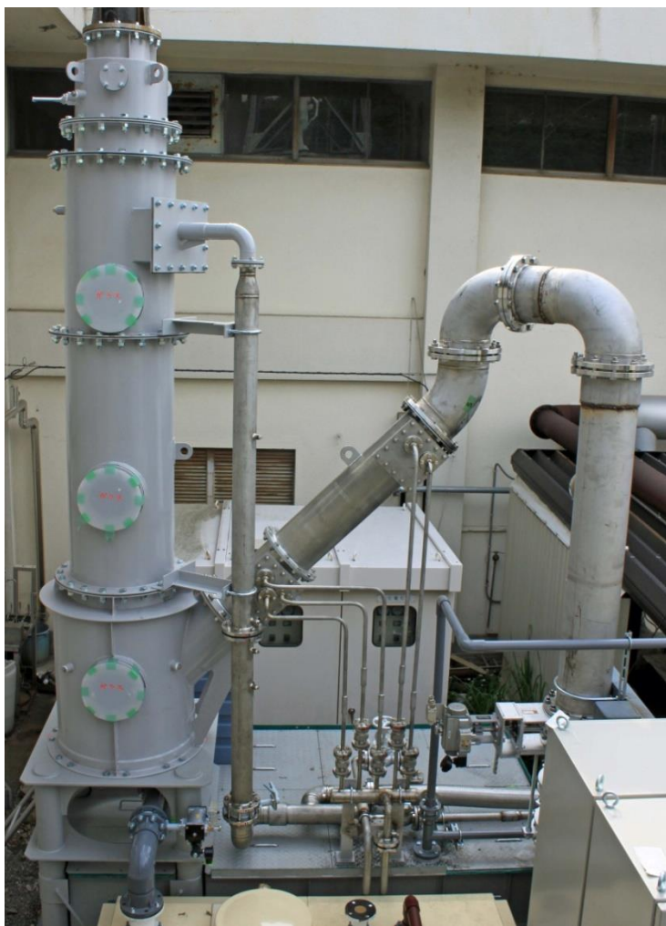
257kW中速エンジン用 高さ:4.3m, 直径:0.55m
