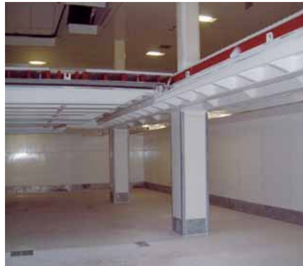
貨物倉内 (上部甲板防熱なし)
