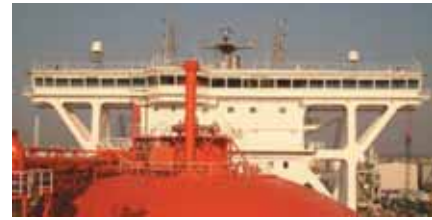
全閉囲型船橋を前方から見た様子
