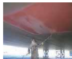
図2 防汚塗料の塗装
