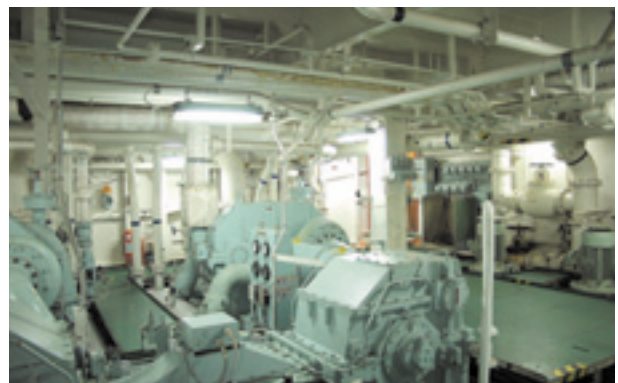
図10 排熱回収により得られた電力を船内電力の一部に供給をしている様子
