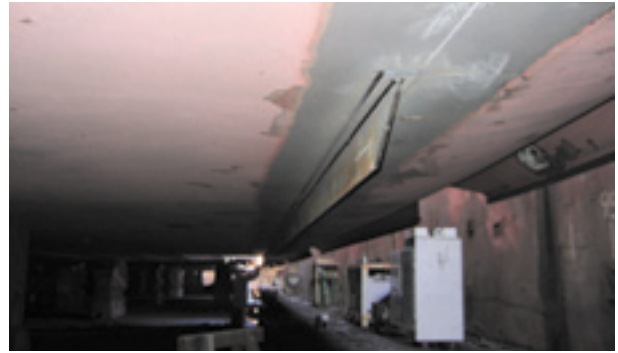
図-4 左舷船底に取り付けられた端板。船首から船尾方向を見えています。
