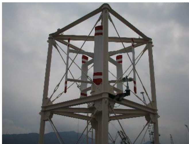
(風力発電装置)
