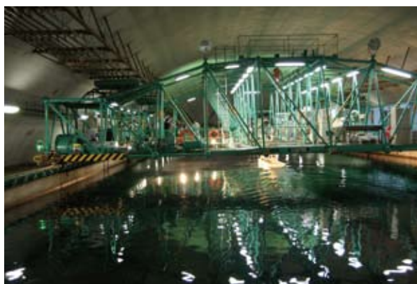
400m水槽の曳引台車に乗る
