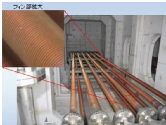
図6 断熱材及び加熱チューブの施工
