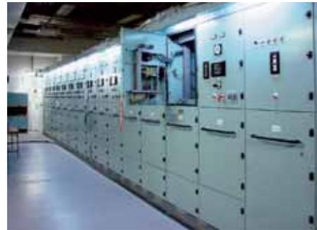
図5 6,600ボルト高圧配電盤
