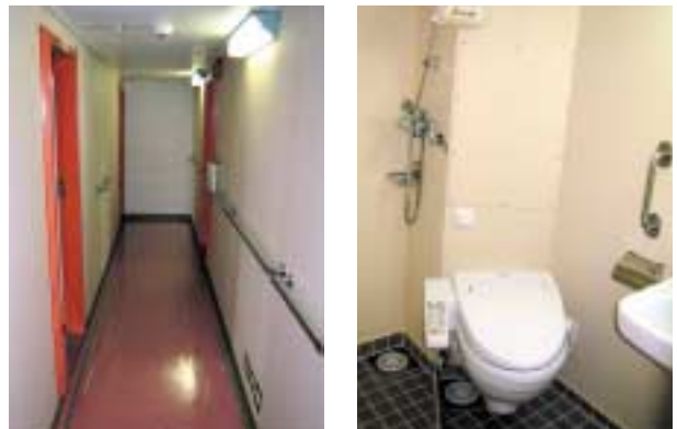
図5 通路とシャワートイレユニット
