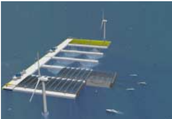
図7 複合利用のためのプラットフォームイメージ（水産（養殖）を主、農業（植物工場等）を従とし、エネルギー源として風力、太陽光等の自然エネルギーを利用）
