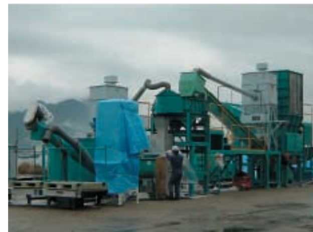
【写真1】FRP船リサイクルプラント
