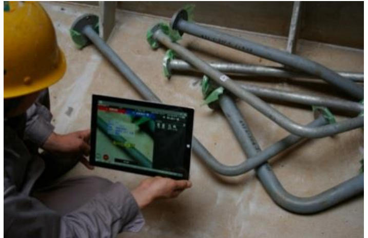
配管情報を確認している様子
