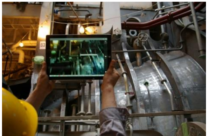
配管位置、配管方法を確認している様子
