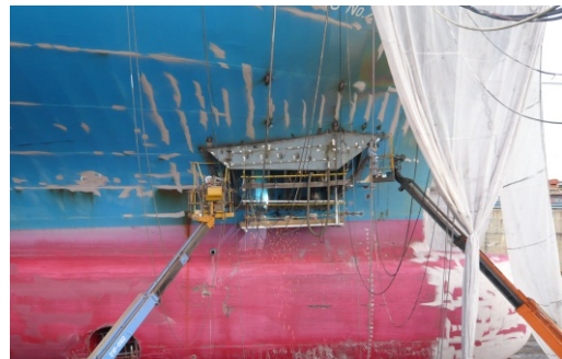
「ステップ」装着工事の様子
