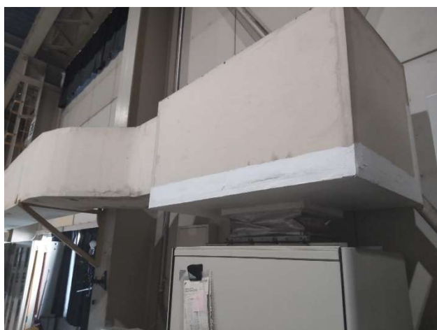
図2 既存エアコン上部のチャンバー
