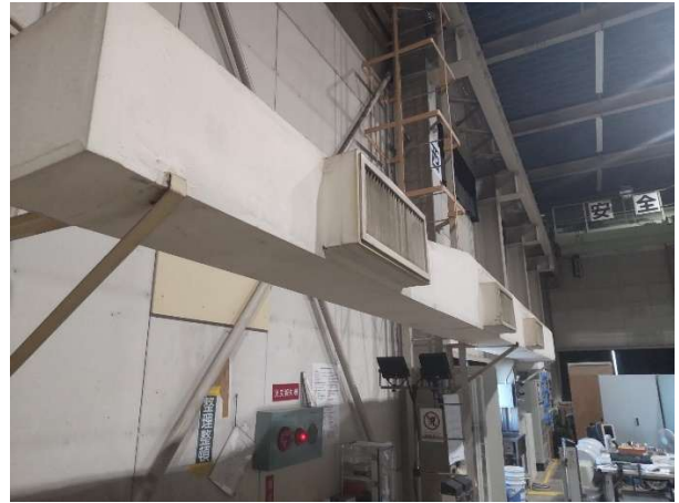
図 4 ダクト固定用アンクル
