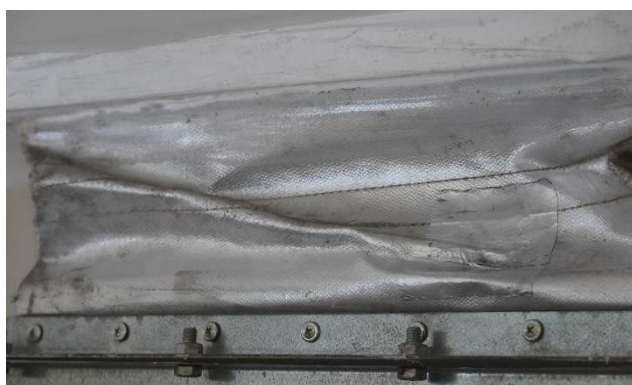
図3 既存エアコン上部のチャンバー接続部
