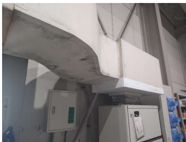
図2 既存エアコン上部のチャンバー
