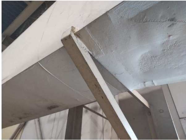
図 4 ダクト固定用アンクル
