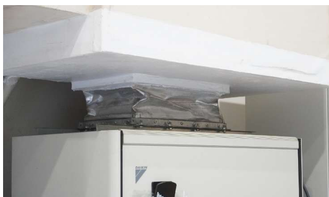
図3 既存エアコン上部のチャンバー接続部
