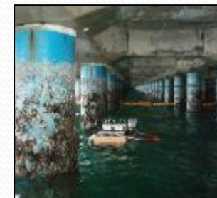
ROVによる橋橋上部工の点検
