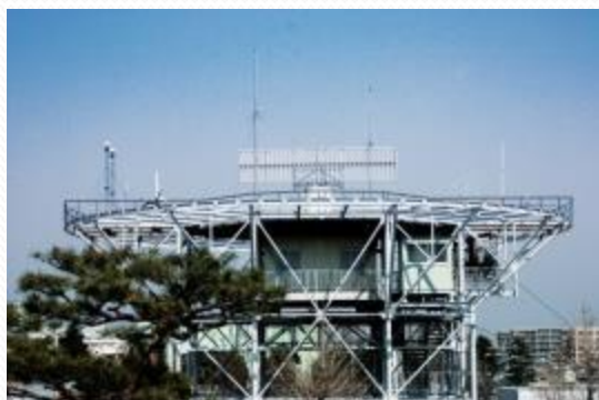
アンテナ試験塔 (SSRモードS地上局)
