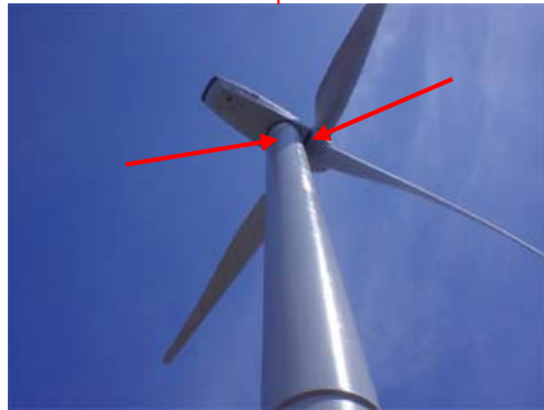
風力発電施設 ・旋回ベアリング(ヨーベアリング) ・ブレードベアリング
