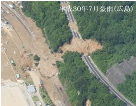
平成30年7月豪雨(広島) 土砂崩れによる道路の寸断 (写真：国土交通省)
