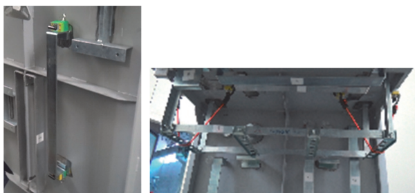
(a) フラットバー電路 (b) ハンガー電路 図1 マグネットベースによる仮止め方法
