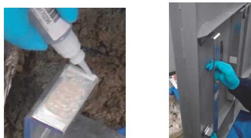
(a) 瞬間接着剤塗布 (b) 仮固定 図2 瞬間接着剤による仮止め方法
