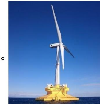
浮体式洋上風力発電設備
