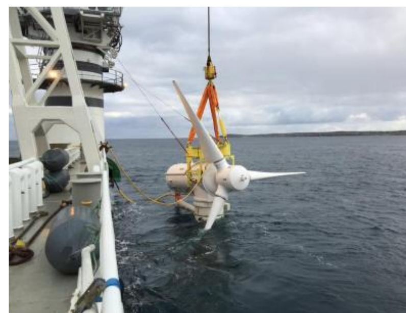
1.5MW潮流発電 (MeyGen、スコットランド)
