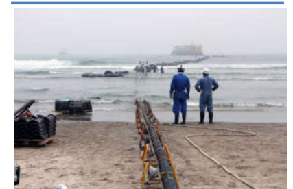
海底ケーブル設置
