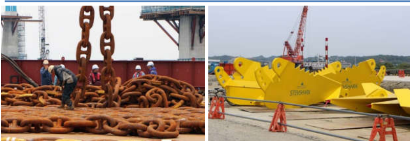
チェーン・アンカーの設置
