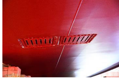
船底の空気吹き出し部
