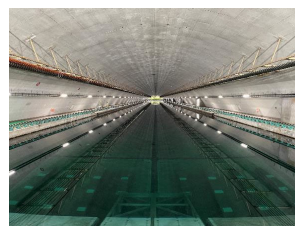
リフレッシュ工事後の400m水槽全景
