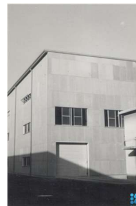
完成した大型キャビテーション試験水槽
