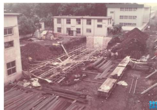
建築中の大型キャビテーション試験水槽
