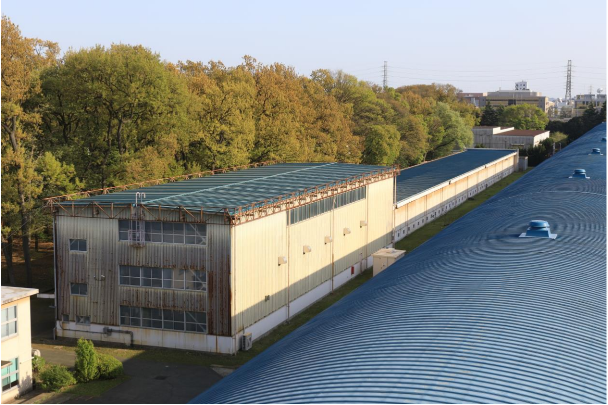
現在：中水槽建屋を400m水槽屋上より見る
