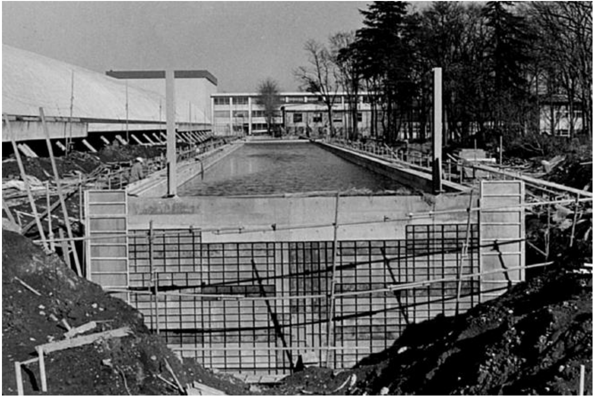
建設時：注水試験の様子を南端より見る
