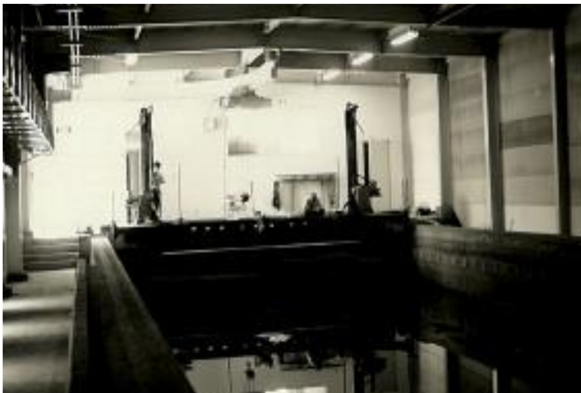
竣工時：造波機を北側より見る
