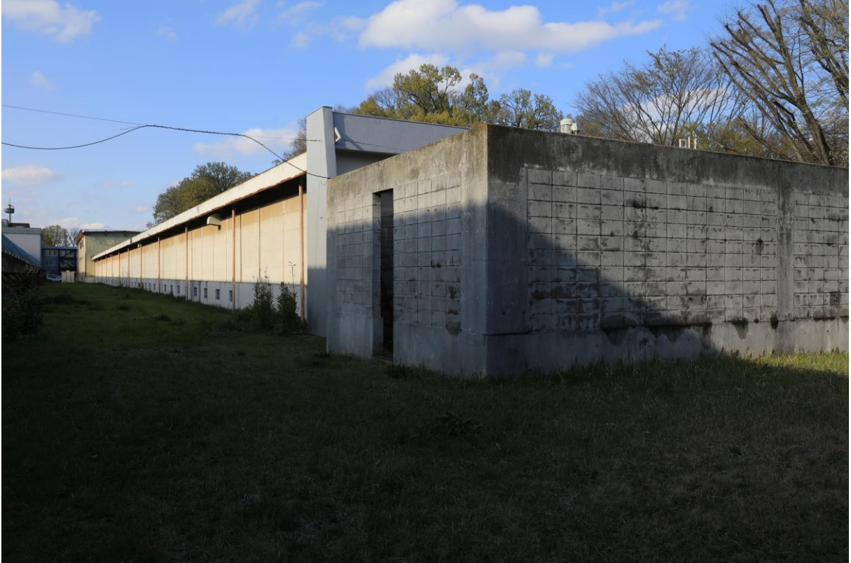
現在：中水槽建屋を南端より見る
