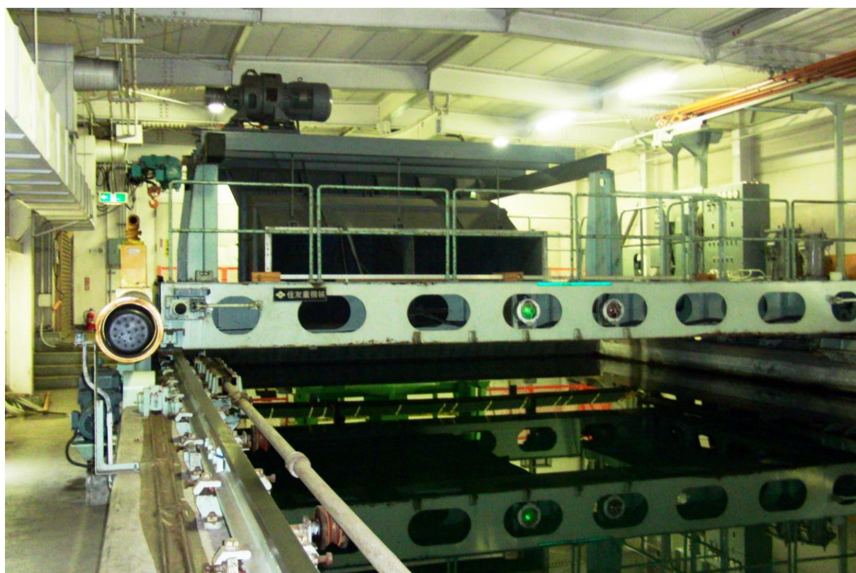
改修前：副台車と排風機を北側より見る
