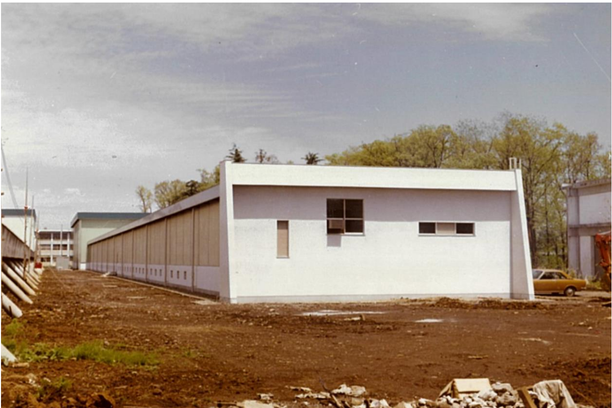
竣工時：中水槽建屋を南端より見る
