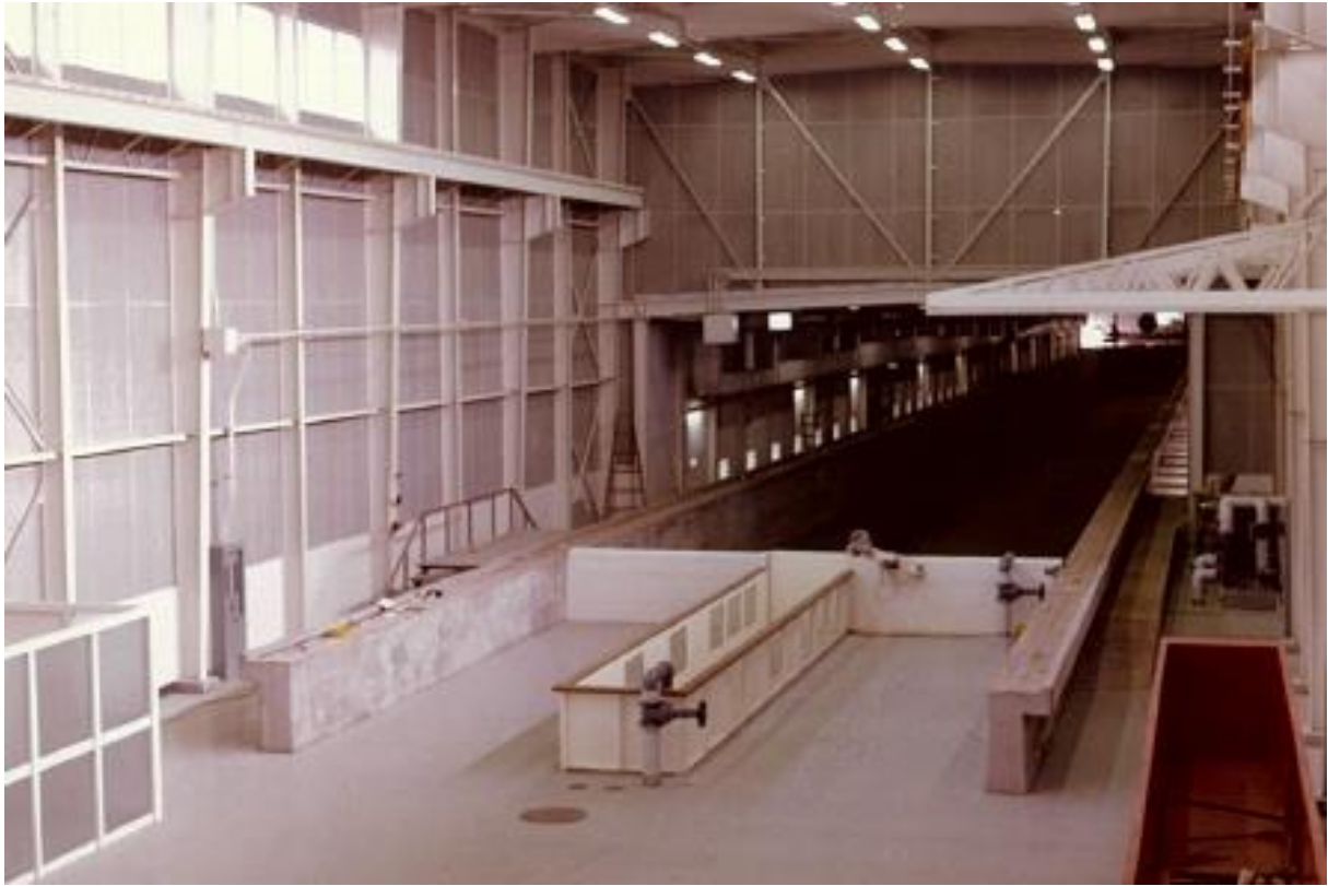
竣工時：水槽および準備場を北西側2階より見る
