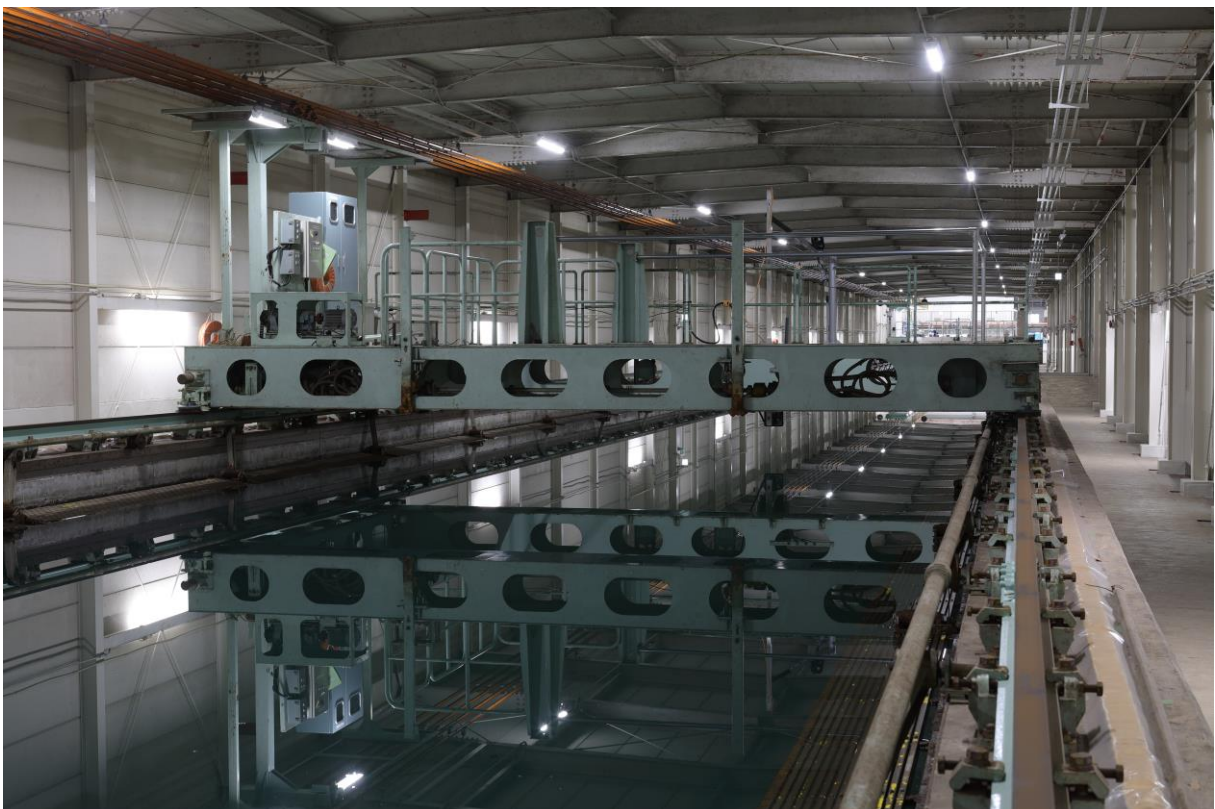
副台車を南側より見る
