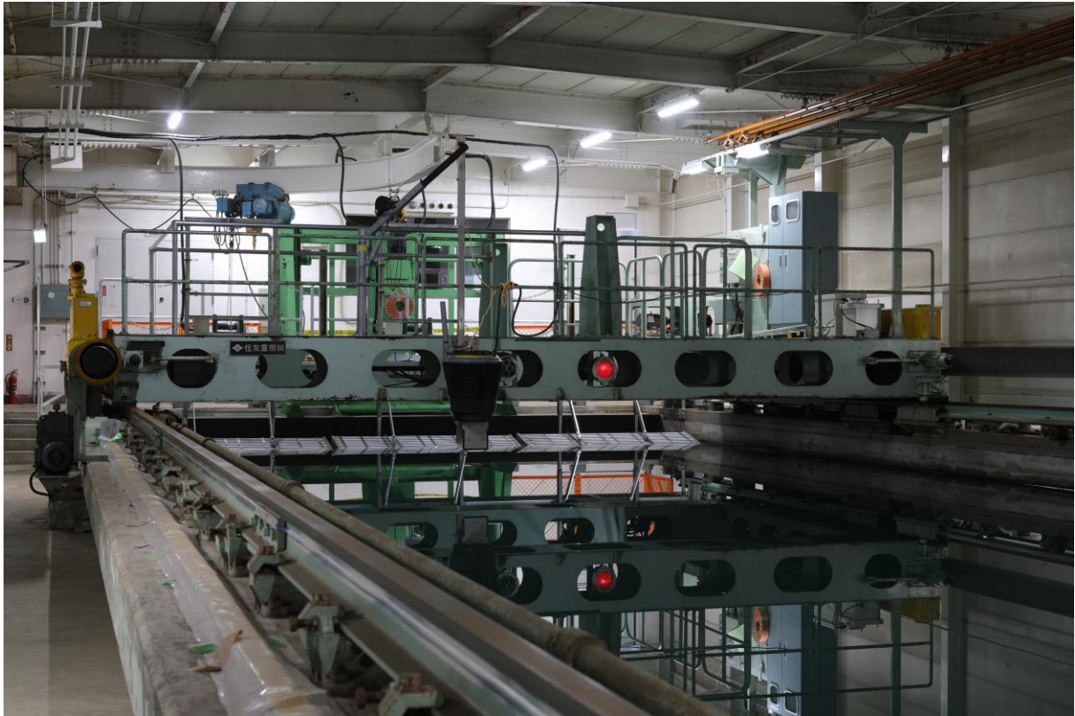
副台車と造波機を北側より見る
