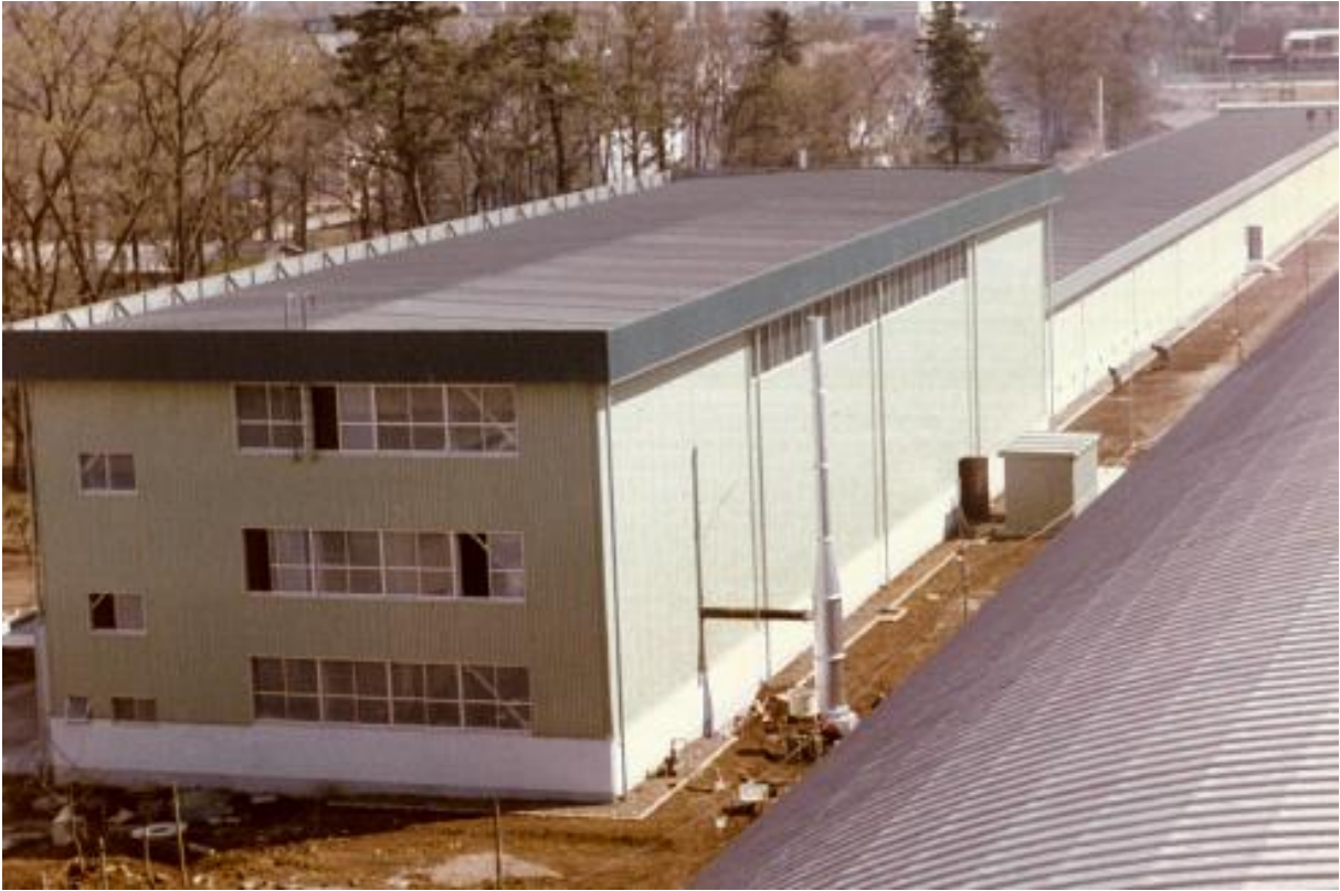
竣工時：中水槽建屋を400m水槽屋上より見る
