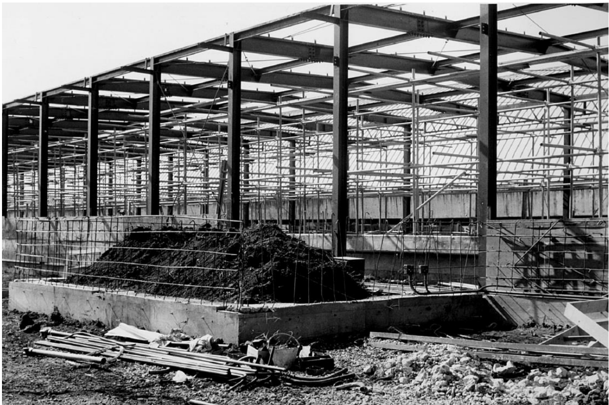
建設時：建屋配筋
