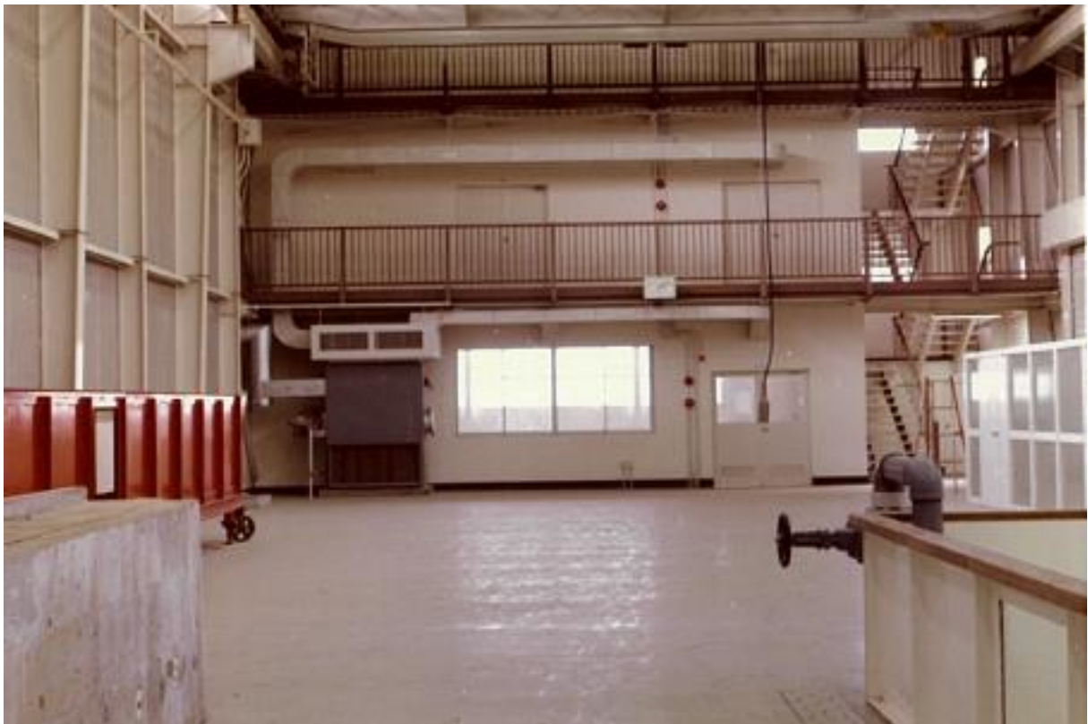
竣工時：準備場と調整室を水槽側より見る
