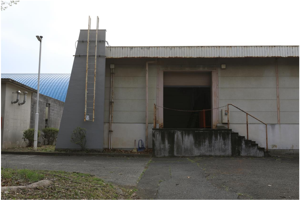
中水槽南端東側
