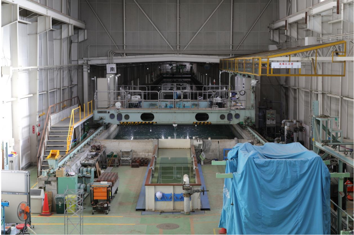
現在：北側2階より見る
