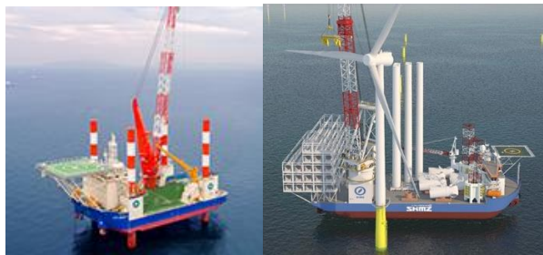
設置工事に用いるSEP船 (出典：(左)五洋建設、(右)清水建設) (SEP：Self Elevating Platform)
