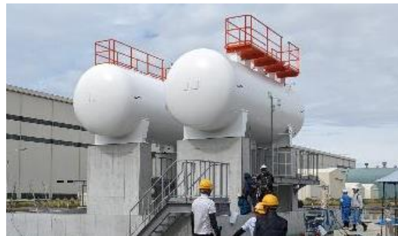
アンモニア貯槽
