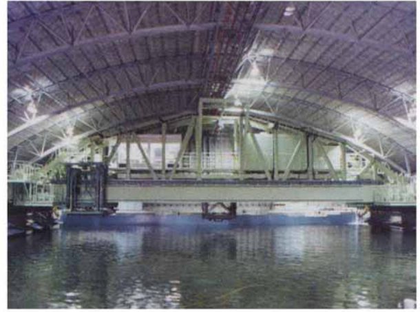
海洋構造物試験水槽
