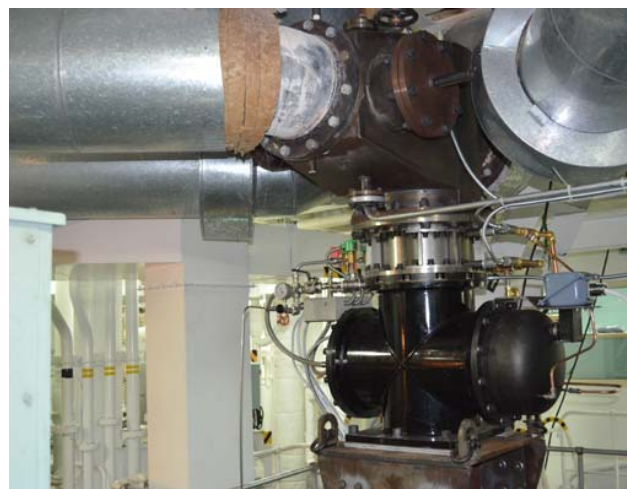
図4 排熱回収スターリングエンジン
