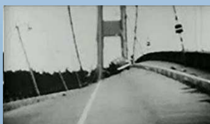
▲タコマナローズ橋の落橋事故 (1940年11月7日)
