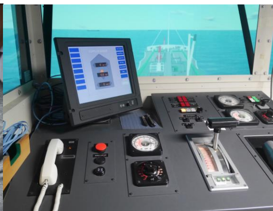
船橋(ブリッジ)でいち早く状況を確認可能に
