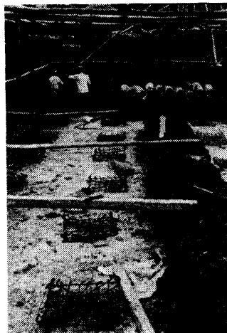
A-4-12 トリミングタンクの基礎工事
