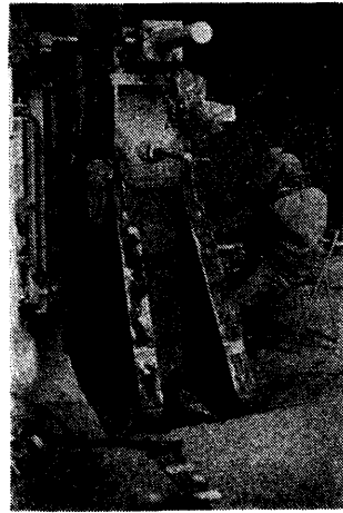
A-4-32 造波装置シリンダ受台の補強
