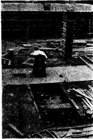
A-4-29 造波装置機械室基礎工事
