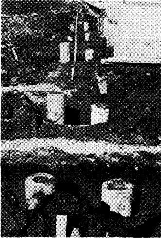
写真 A-7 建屋基礎杭
