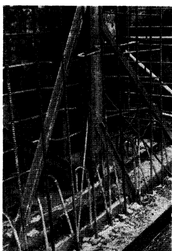
写真 A-5 造波機基礎（水槽南端の壁を外側から見る）
