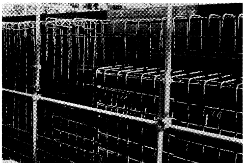
写真 A-3 側壁配筋, 南端部非常制動等の基礎
