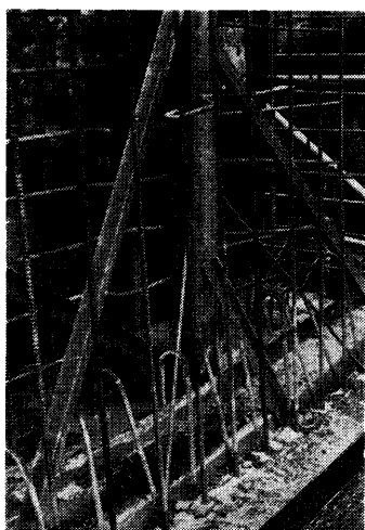
写真 A-5 造波機基礎 (水槽南端の壁を外側から見る)
