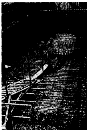
写真一A.4 配筋
