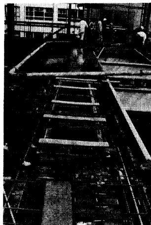
写真一A.9 2階床打ち
